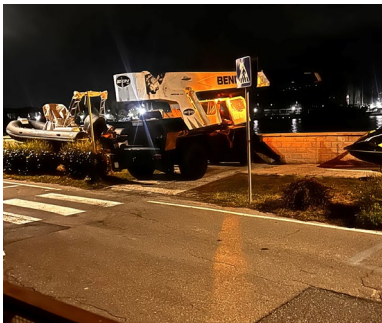
autogru al lavoro sul lungo fiume
