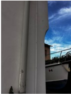
spigolo della palazzina smussato per consentire la manovra
